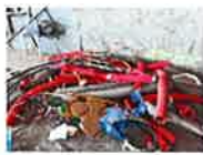
12/09/2018 - Déchets de chantier
